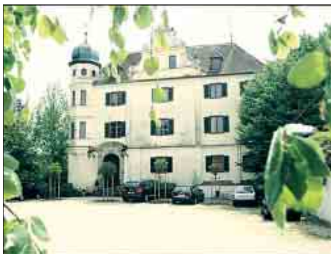
Ein Schloss aus dem zwölften Jahrhundert – in dem Baron Gumpenberg schon seine Kindheit verbracht hat.
